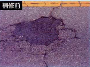
陥没部分補修
