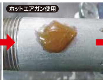
補修箇所を温め、塗布し20分程度熱されると金色に変色。
