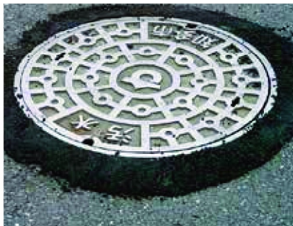
マンホール部分
