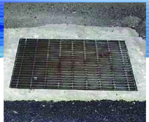
グレーチングまわり
