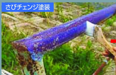
下地処理(3種ケレン)後にさびチェンジ塗装。
