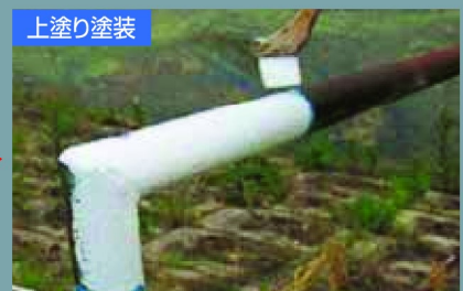
乾燥後、一般塗料で上塗り塗装。
